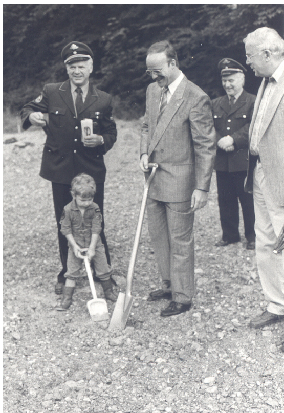
Beim Spatenstich für das Feuerwehrgerätehaus in der Ammerau
