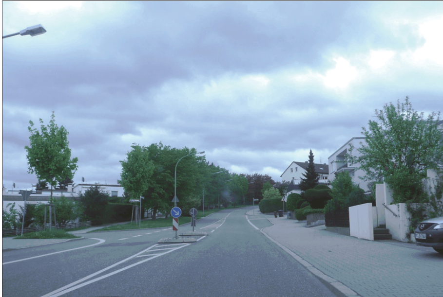
Abb. 6: 2-streifige Hauptverkehrsstraße - ab 7 m ausreichende Breite für Schutzstreifen (Tiefenbronner Str.)
