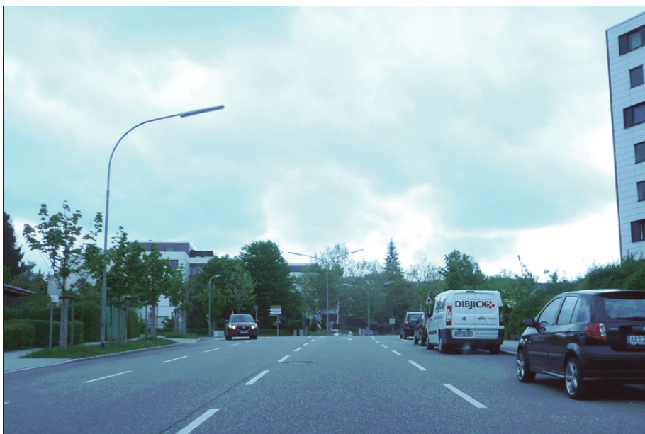
Abb. 5: 4-streifige Hauptverkehrsstraße - Umnutzung der rechten Fahrstreifen zum Parken (Tiefenbronner Str.)
