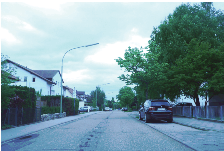
Abb. 3: Straße in einer Tempo-30-Zone, die ausreichend Raum für Radverkehr bietet (Werner-Siemens-Straße, Südweststadt)
