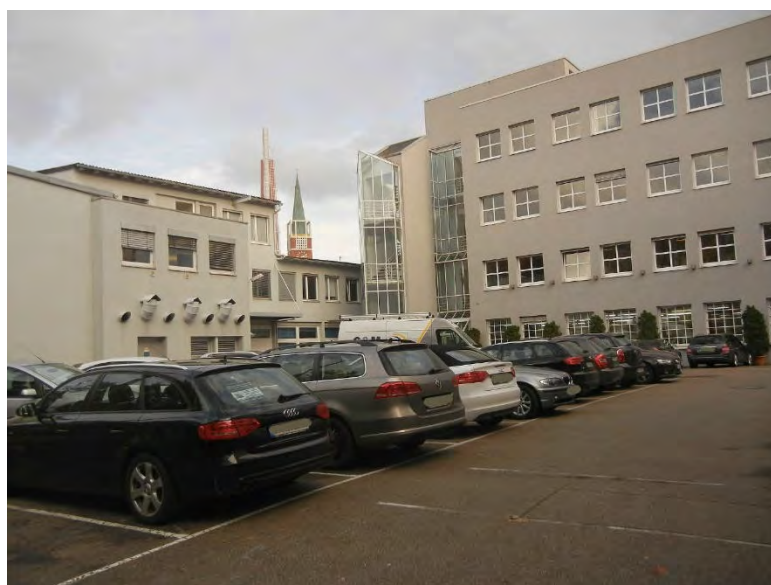
Abb. 9-34: Parkplatz an der Bleichstraße.
