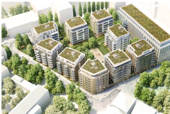
Abb. 9-48: Beispiel für eine teilweise aufgelockerte Bebauungsstruktur und Einsatz von Dachbegrünung. Rosenberghöfe Stuttgart (/20/).
