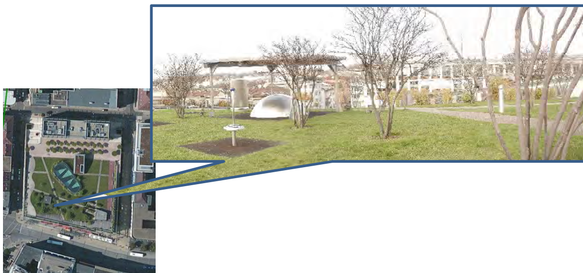
Abb. 9-29: Luftbild der Schlössle-Galerie und Ausschnitt des Geländes mit Spielbereich.
