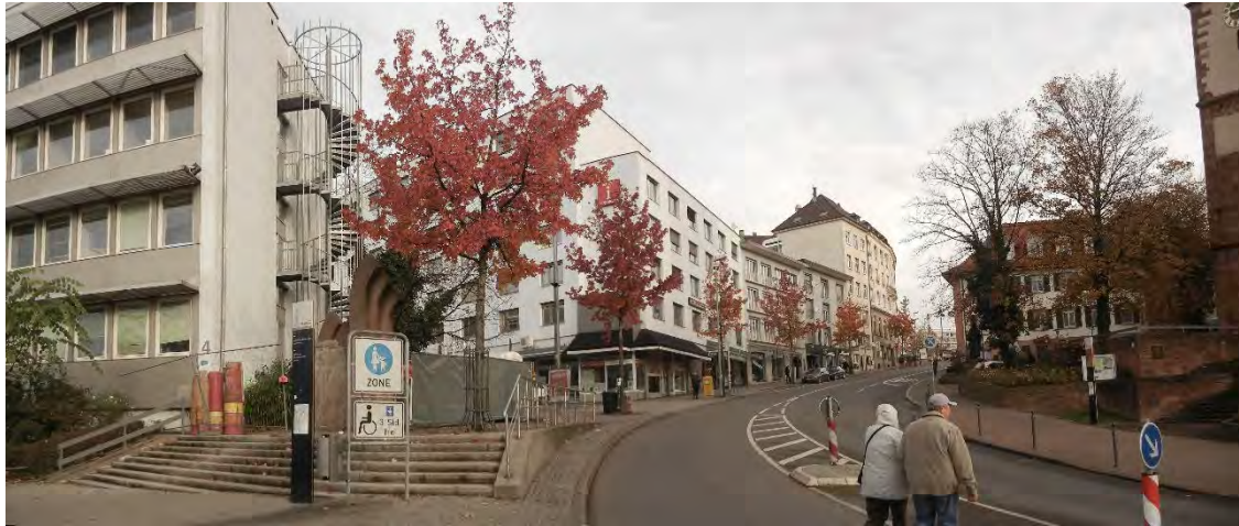
Abb. 9-45: Bestehende Verbindung zwischen Blumenhof (links anschließend) und dem Grünbereich um die Schlosskirche (rechts).
