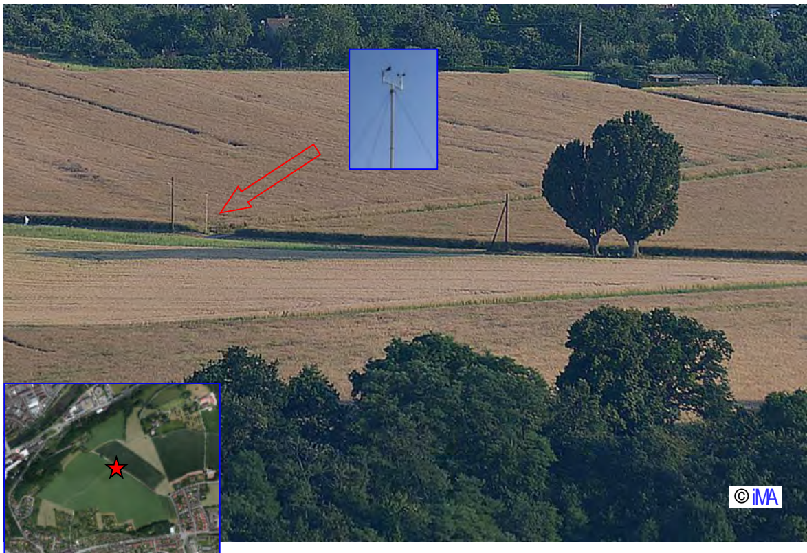
Abb. 6-6: Windmessenanlage auf der Freifläche am Buckenberg.
