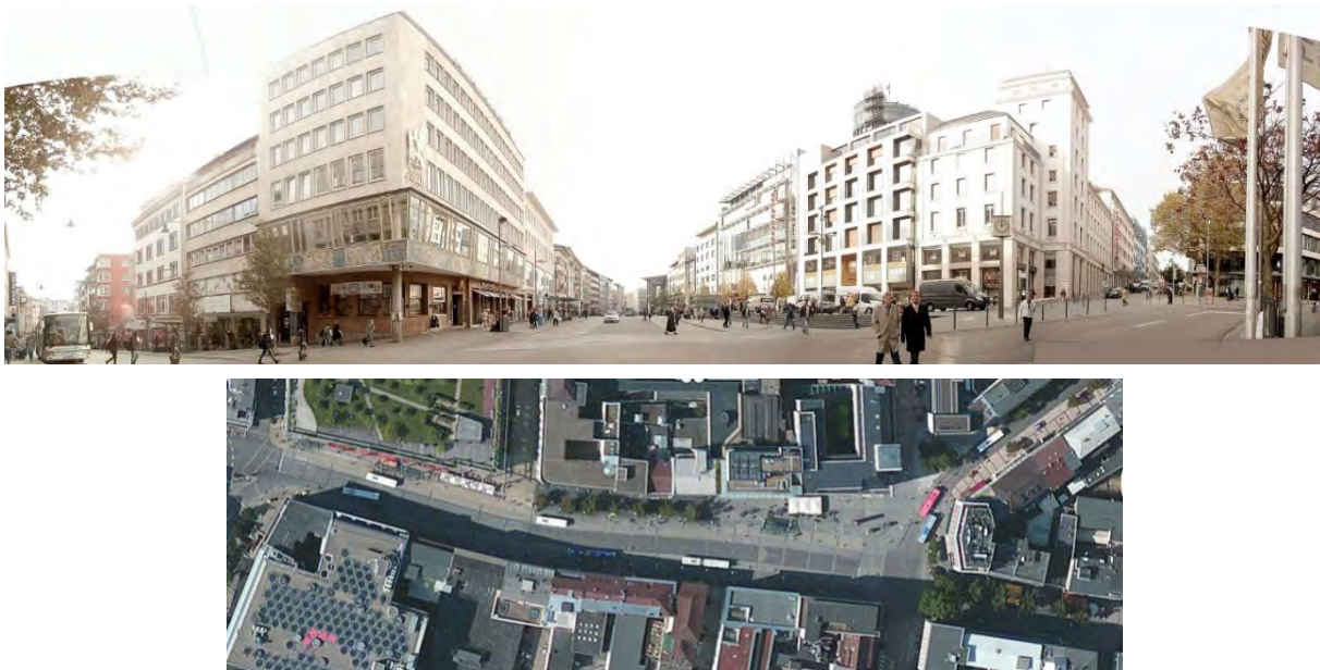
Abb. 9-27: Blick auf den Leopoldplatz in Richtung Westen (oben) und Luftbild (unten).
