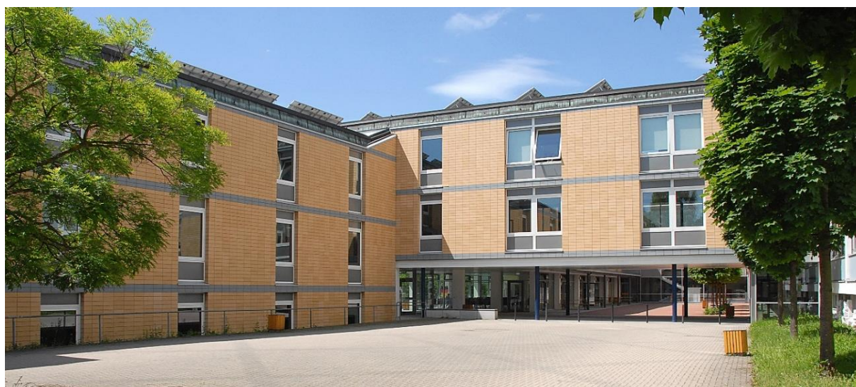
Abbildung 21 - Das Kepler-Gymnasium ist eines der 38 Schulgebäude mit Sporthallen, welches im Energiebericht aufgenommen wurde.
