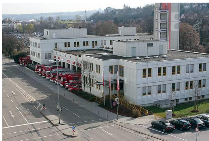
Abbildung 25 - Die Hauptfeuerwache als Standort der Berufsfeuerwehr Pforzheim ist ein hochtechnisierter Gebäudekomplex mit den verschiedensten Nutzungen.
