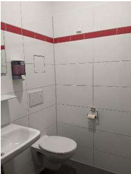
Abbildung 98: Sanierung eines Teils der Sanitärbereiche bei den Ruheräumen
