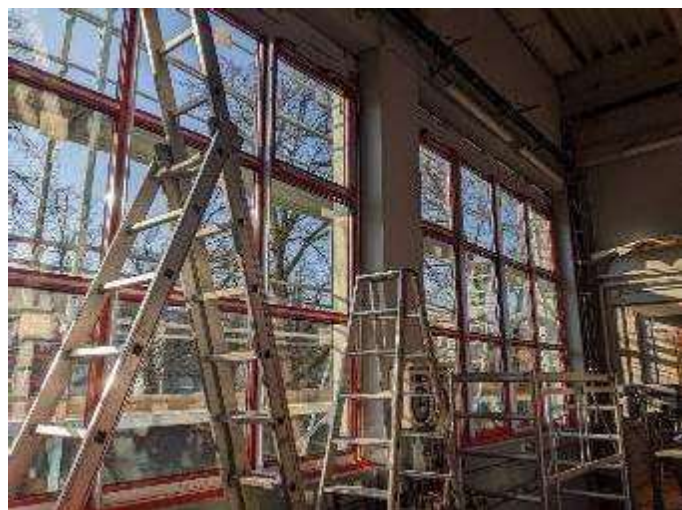
Abbildungen 93-94: Austausch großer Fensterelemente in der Waschhalle sowie in der Kfz-Werkstatt
