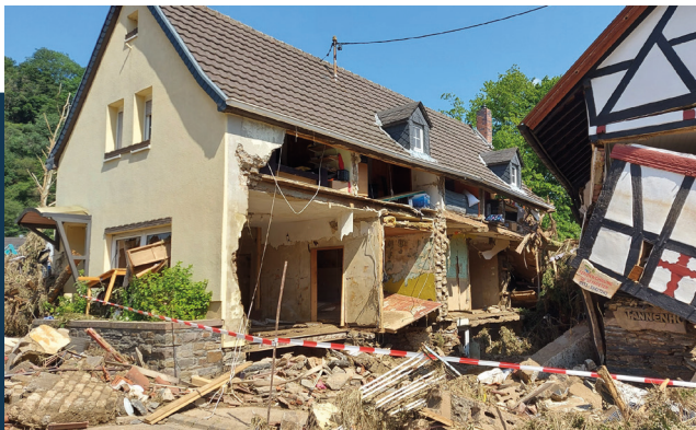
DURCH DAS HOCHWASSER ZERSTÖRTES GEBÄUDE IM AHR TAL
