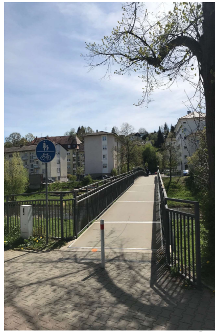
Brücke Hans-Sachs-Straße zur Steubenstraße
