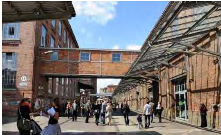
Kohlebunker / Industriekultur: Baumwollspinnerei, Leipzig
