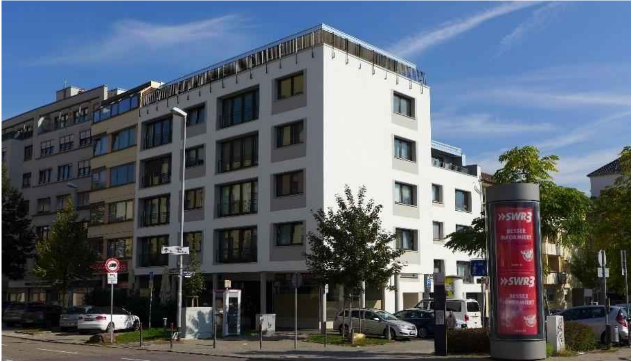
Abb. 12: Emma-Jaeger-Str. 1 nach der Sanierung Quelle: Planungsamt, Stadt Pforzheim
