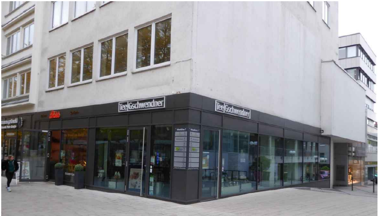
Abb. 15: Fassadenförderprogramm, Westliche Karl-Friedrich-Straße 7
