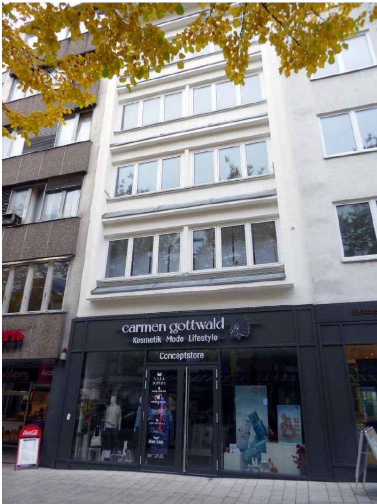
Abb. 16: Fassadenförderprogramm, Westliche Karl-Friedrich-Straße 5
