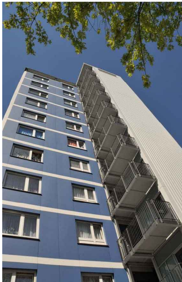
Calwer Straße 2 nach der Sanierung
