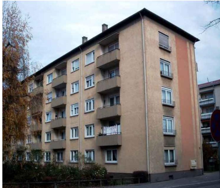
Calwer Straße 12 vor der Sanierung
