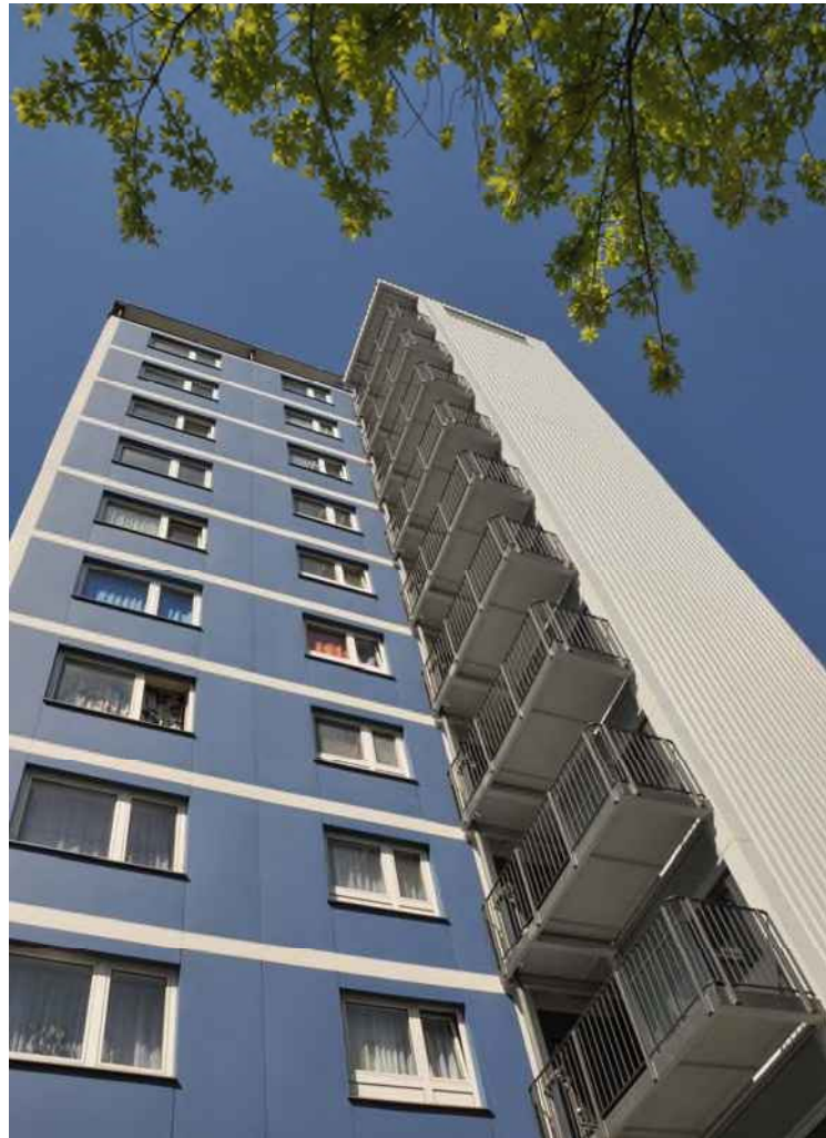
Calwer Straße 2 nach der Sanierung
