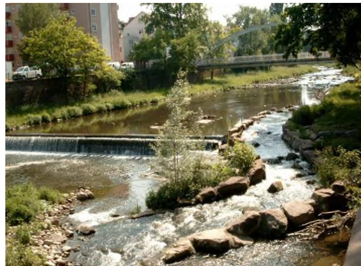
Nagold nach der Renaturierung
