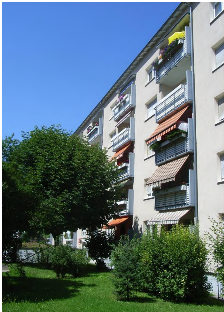
Calwer Straße 8 nach der Sanierung
