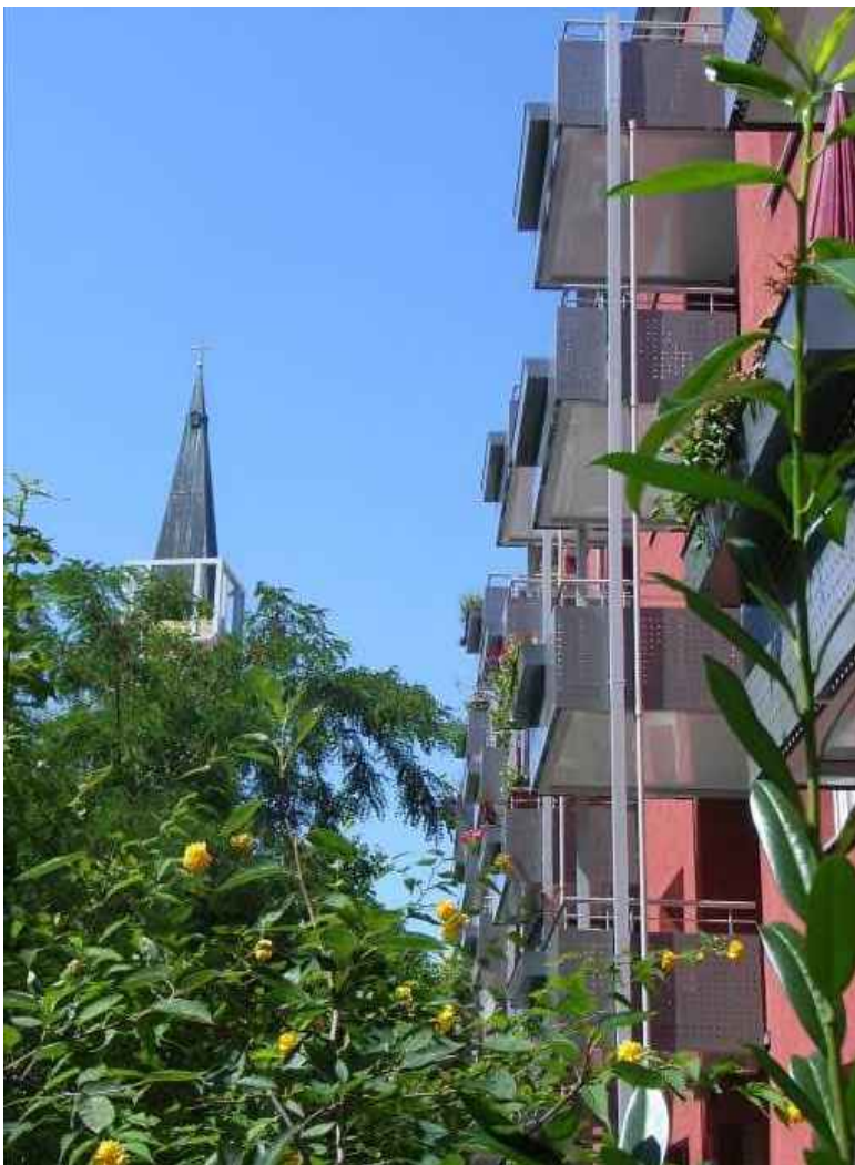
Calwer Straße 12 nach der Sanierung
