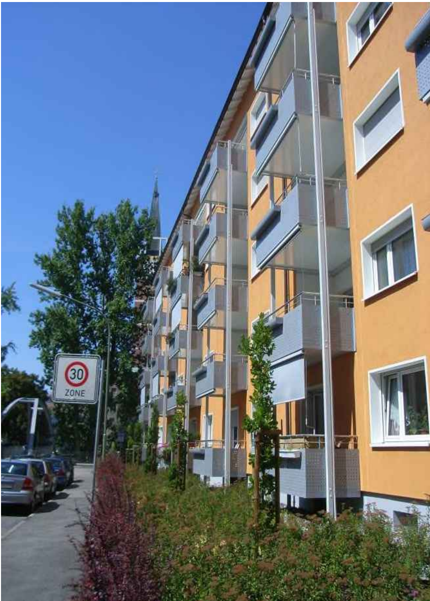
Calwer Straße 14 nach der Modernisierung
