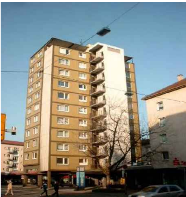
Calwer Straße 2 vor der Sanierung
