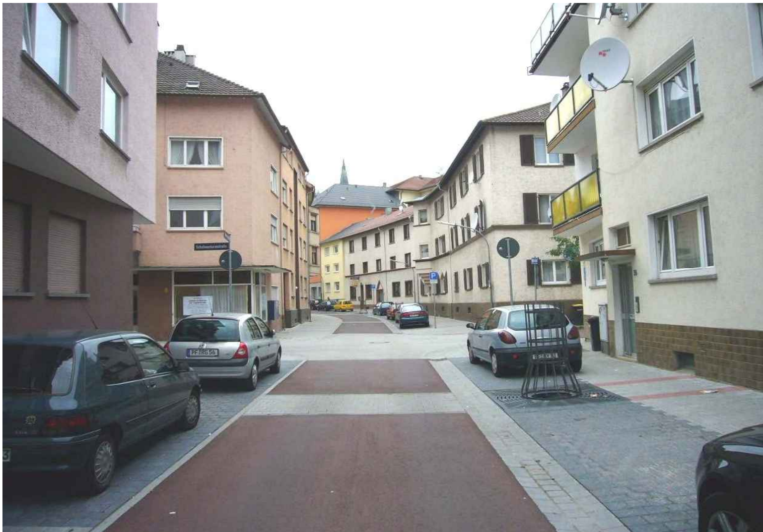
Untere Augasse nach der Umgestaltung
