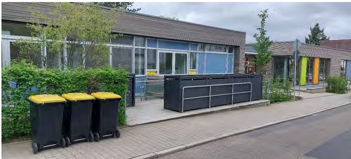
Abb. 40: Kita Friesenstraße, Nordfassade Bestandsgebäude
