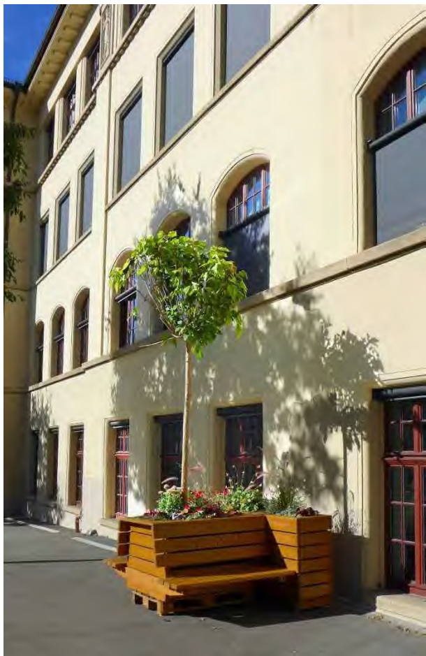
Abb. 33: Wanderbaum vor Nordstadtschule
