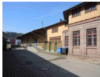
Ansicht der Güterhalle (70a) von Nordosten
