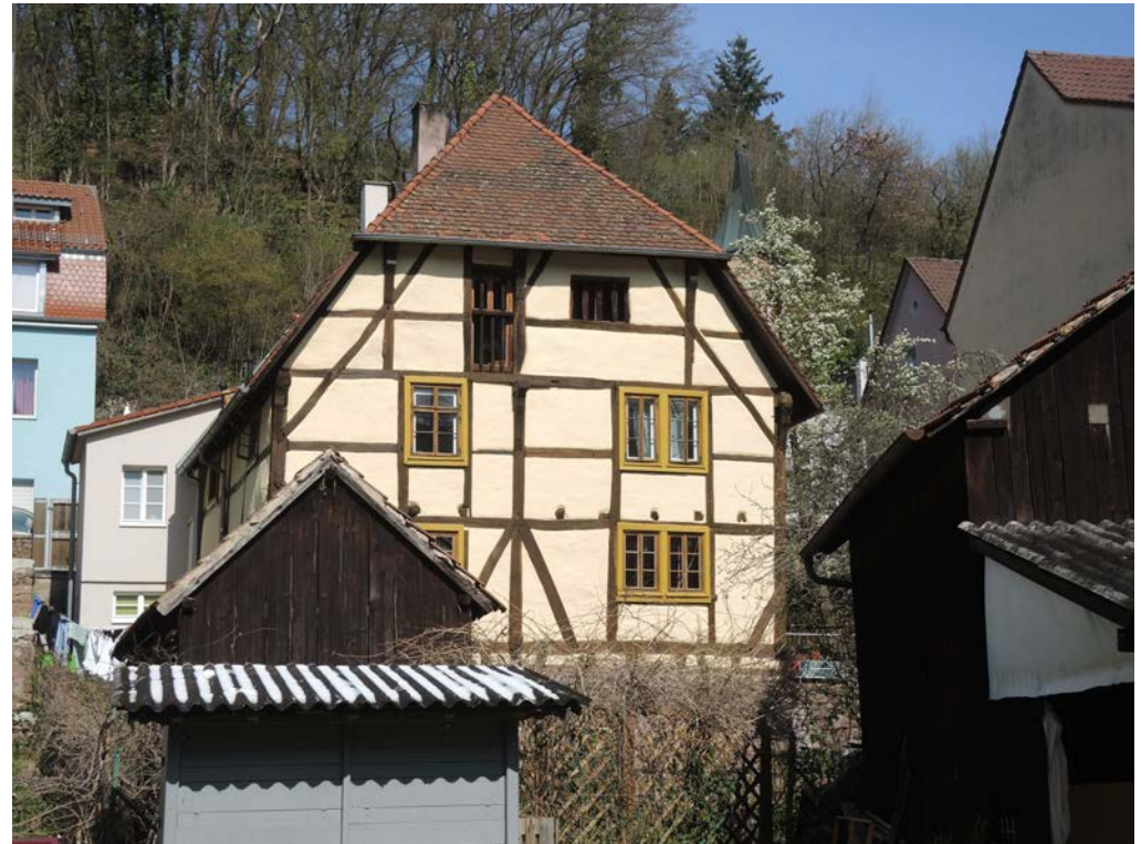
Abb. 6 - Ansicht des Gebäudes Belremstraße 33 mit seinem spätmittelalterlichen Fachwerkgefüge der Zeit um 1477. In Weissenstein haben sich zahlreiche Gebäude des 15.-18. Jahrhunderts erhalten (2022).
