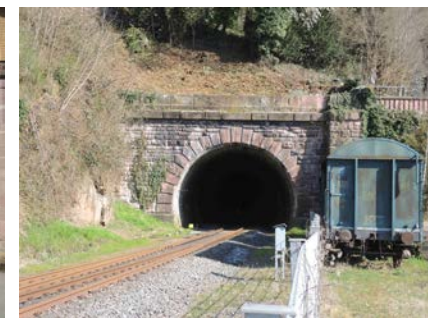
Ansicht des Schloßbergtunnels
