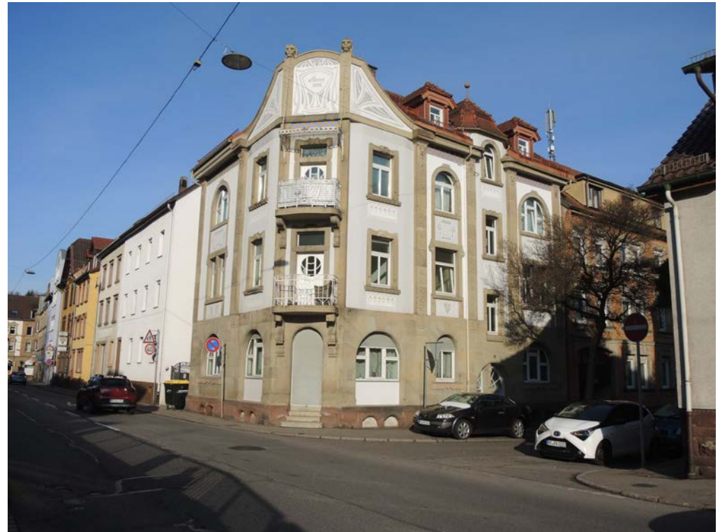
Abb. 7 - Ansicht des Gebäudes Ganghoferstraße 1 an der Einmündung in die Hirsauer Straße. Dillstein wird vermehrt von stattlichen Wohn- und Geschäftshäusern der Zeit um 1900 geprägt (2022).
