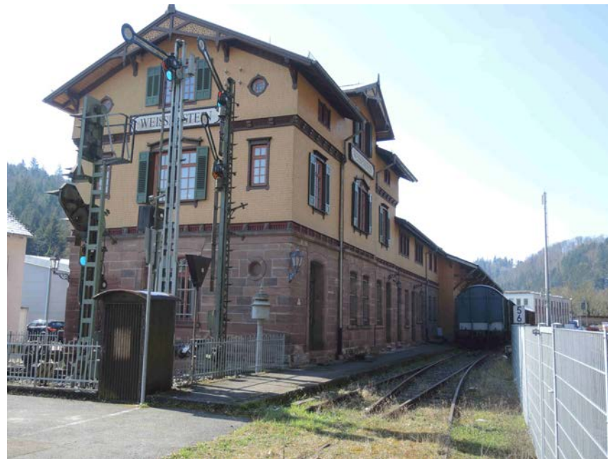
Ansicht des Empfangsgebäude (Nr. 70) von Norden
