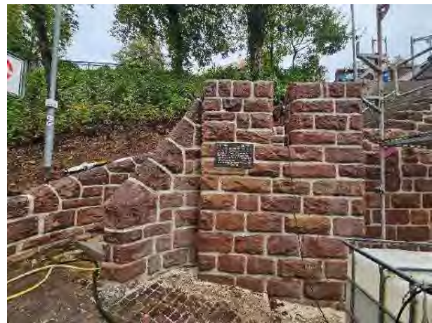
Neu ausgefugter Mauerbereich
