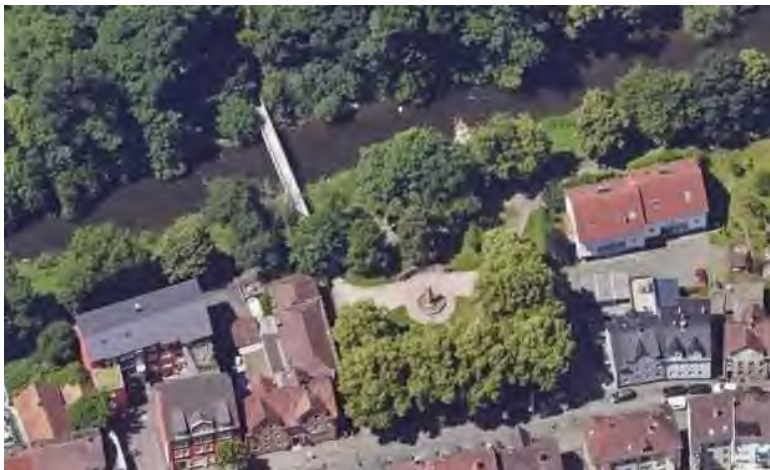
Katzensteg Quelle: Vermessungs- und Liegenschaftsamt, Stadt Pforzheim
