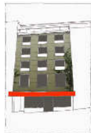
.....mit einer ungewöhnlichen Verkleidung und einem großen Vordach, dass das Erdgeschoss erdrückt.
