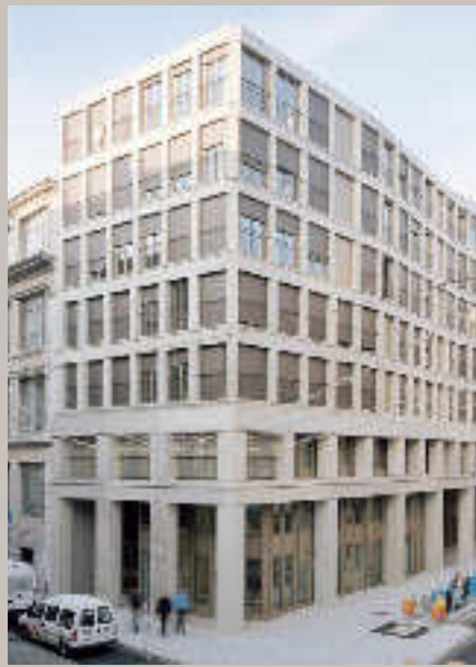
Geschäftshaus Genf, Sergison Bates Architects
