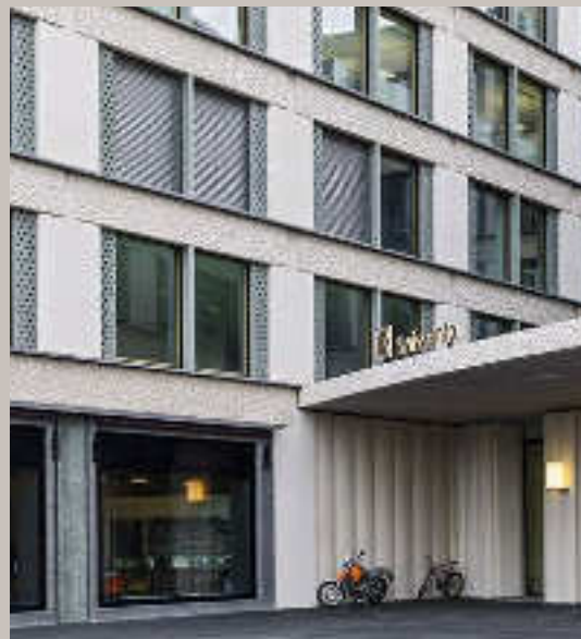
Europaallee Zürich, Arch. Caruso St. John
