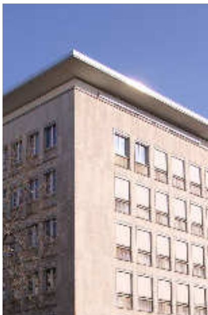
Vorbildliches Beispiel eines auskragenden Daches über einem Staffelgeschoss als oberer Abschluss der Fassade
