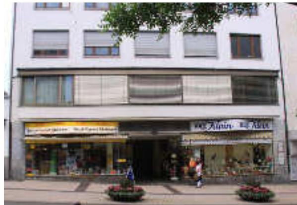
Häufige Kombination von Fassadentypen: Bandfassade im 1.OG, darüber Lochfassade
