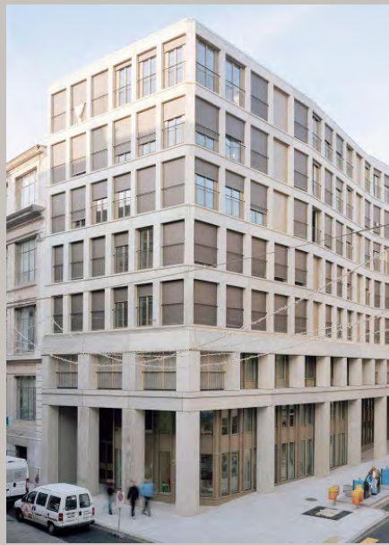
Geschäftshaus Genf, Sergison Bates Architects
