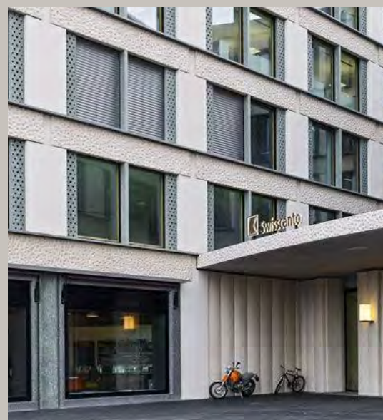
Europaallee Zürich, Arch. Caruso St. John
