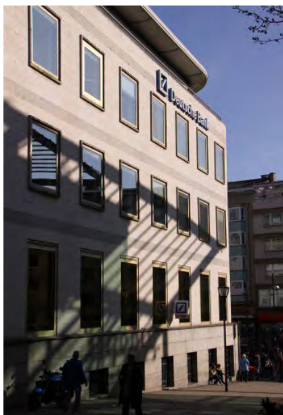
Nicht viel mehr als gut proportionierte und detaillierte Fenster in einer Wand aus einem angenehmen Material.....
