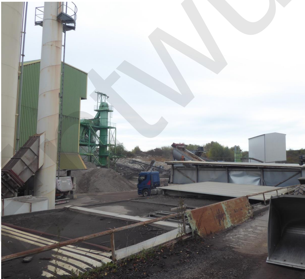
Abb. 4.4: Benachbarter Anlagenstandort, Blick aus südlicher Richtung
