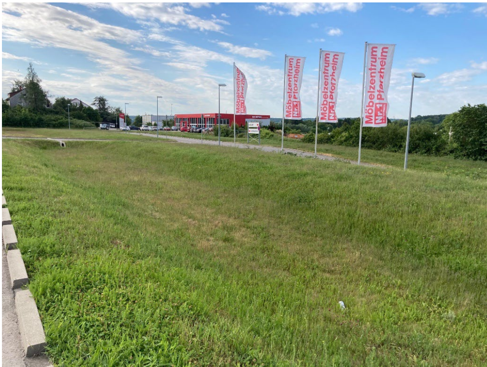
Abb. 2: Entwässerungsmulde über dem Obsthofstollen
