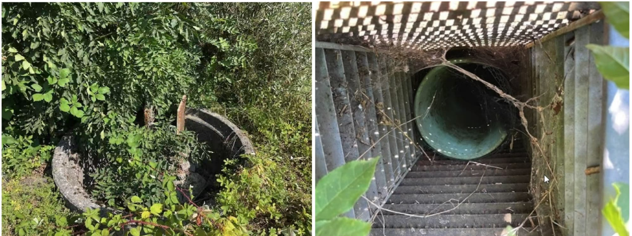
Abbildung 2-8: Außenansicht Auslaufbauwerk (links) und Innenansicht Auslaufbauwerk (rechts)[3]
