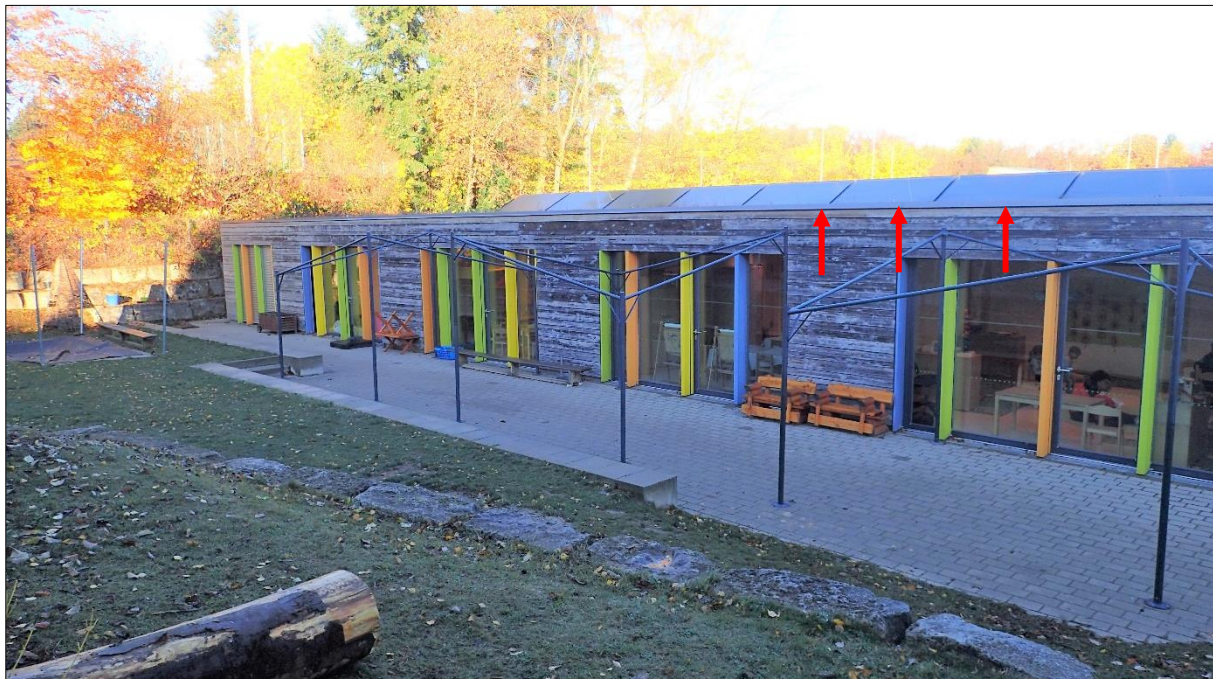
Abbildung 3: Südfassade der Evangelischen Kindertagesstätte „Fuchsbau“ mit Attika (rote Pfeile)
