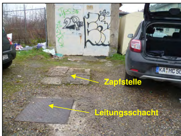
Foto 5: Leitungsschacht und Zapfstelle
