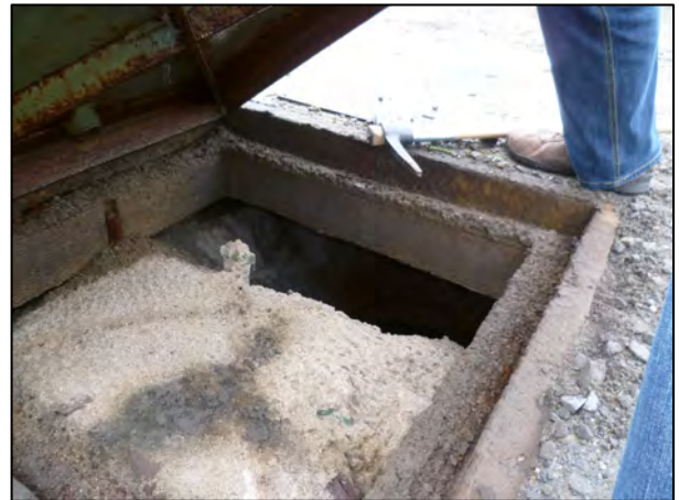
Foto 4: „Großer“ Schachtdeckel Tank 3
