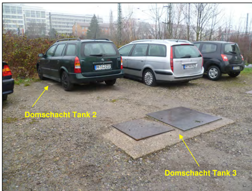
Foto 2: Domschacht Tank 3 (unter dem Pkw links ist der Domschacht von Tank 2 zu erkennen)
