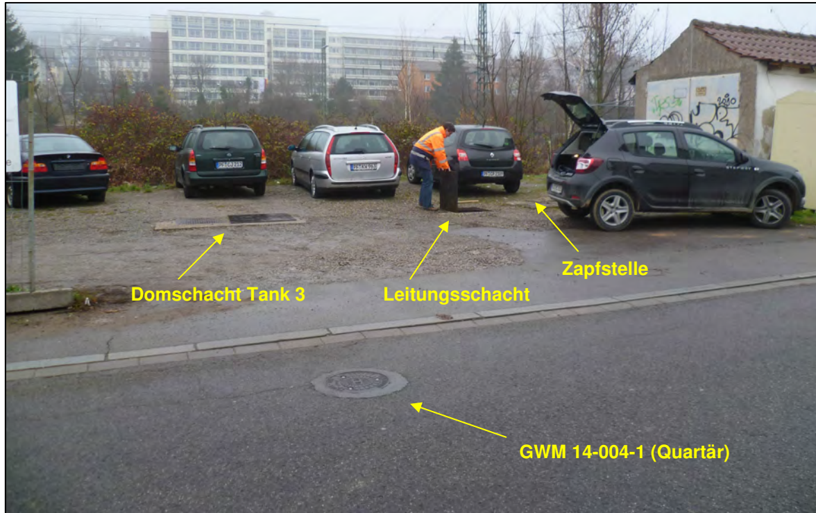
Foto 1: Blick auf die ALVF 7061-14-004 aus Richtung Tunnelstraße
