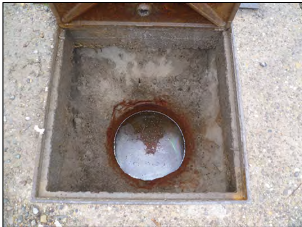
Foto 3: „Kleiner“ Schachtdeckel Tank 3
