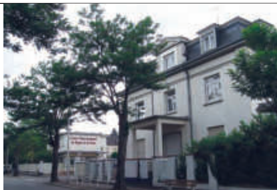
Altersheim in Colmar (Verwaltungsgebäude und Eingang 2011)
